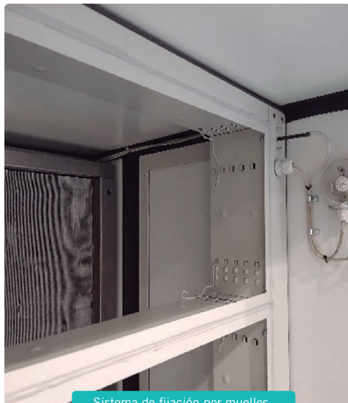
Sistema de fijación por muelles
