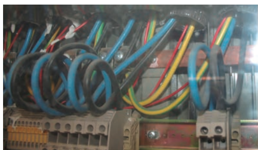
> Origen de derivaciones individuales en las bornas de salida de una centralización de contadores CC)
