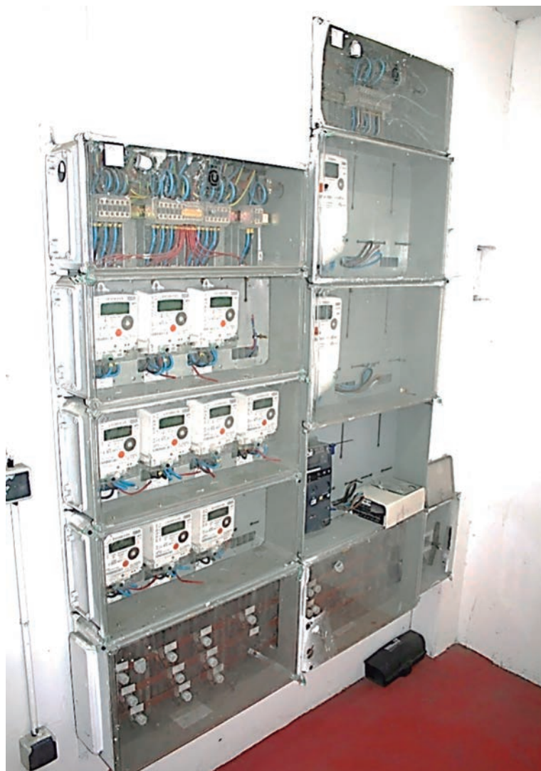
> Centralización de contadores de un edificio de viviendas
