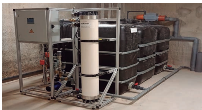
> Equipo de tratamiento de aguas grises por membranas de ultrafiltración externas (MBR Multibore)
